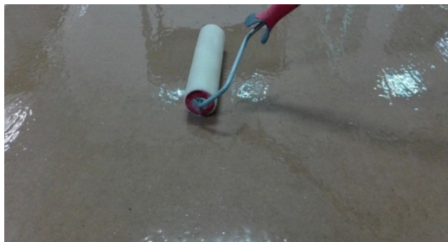
Application of Aquathane Primer W
