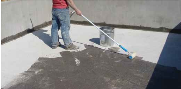
Application of Aquathane Primer PU
