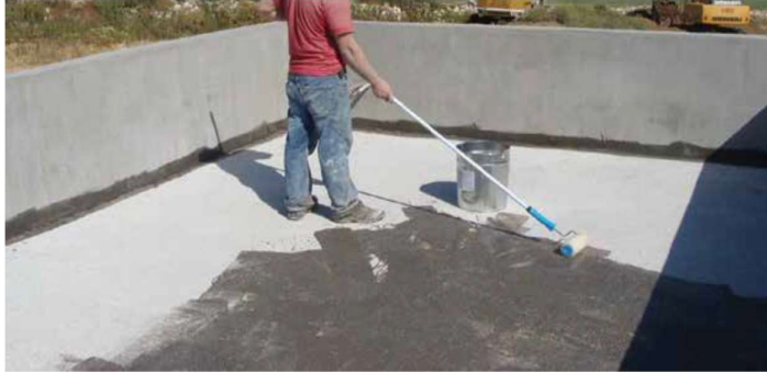
Application of Aquathane Primer PU
