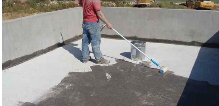
Application of Aquathane Primer PU
