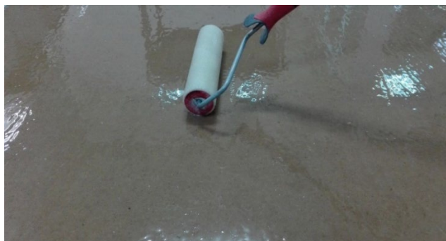
Application of Aquathane Primer W
