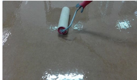
Application of Strongcoat Primer
